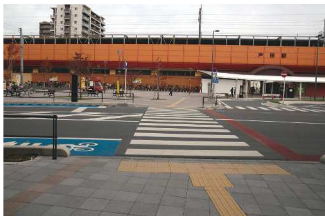
信号が設置されていない戸田駅西口前の横断歩道
